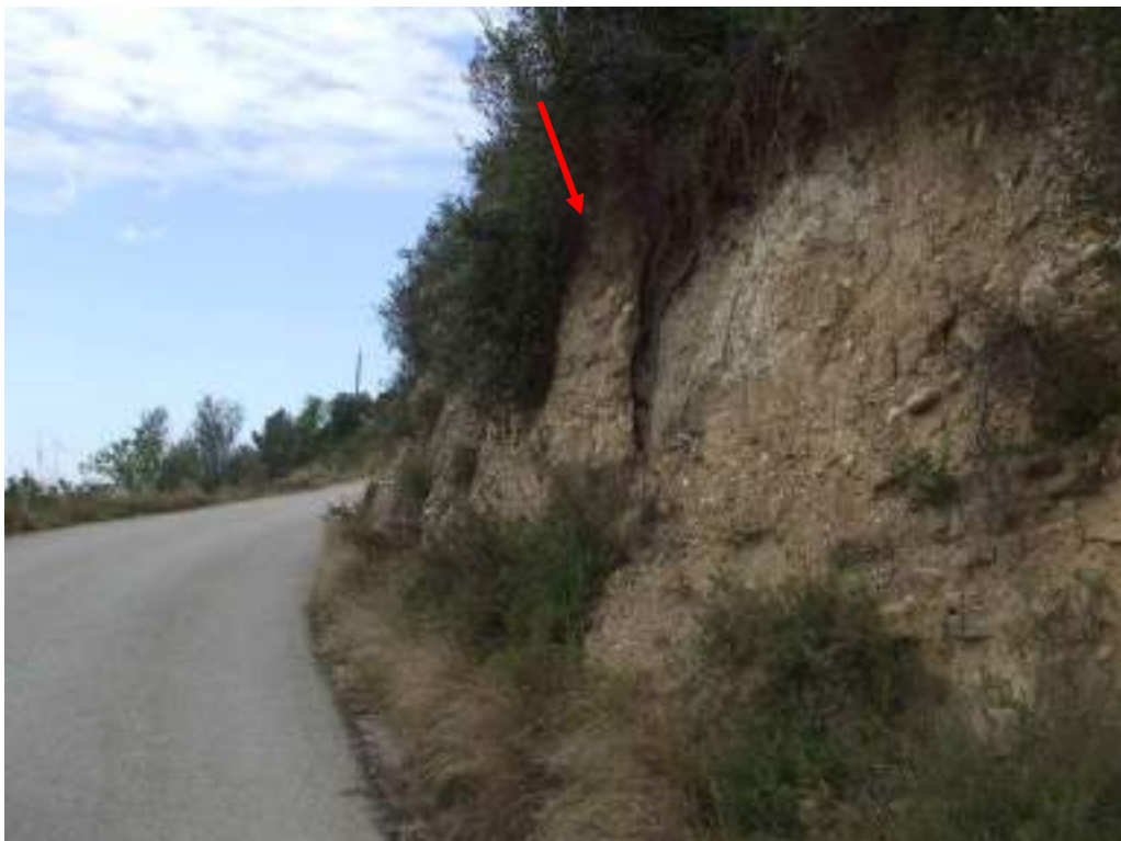
Fotografia 5: Bloc de conglomerat individualitzat en el talús del camí cap a l'Oasi, a les Boïgues.
