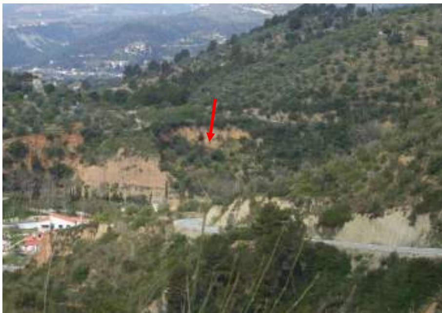
Fotografia 14: Panoràmica del sector esclavissat des de la carretera d'accés a l'urbanització de Ribes Blaves.
